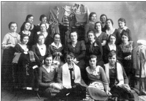
Kurz ručních prací
