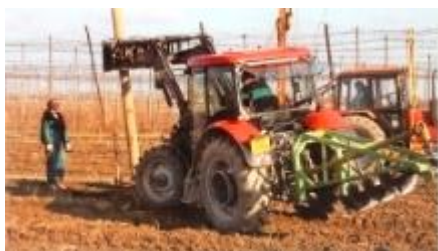
Nová technologie stavby nízkých chmelnicových konstrukcí
