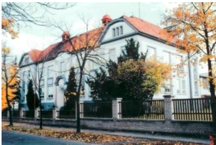
Historická budova SZTŠ v Žatci
