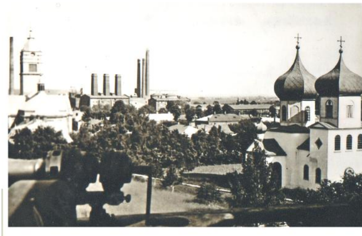
Totěž, ale asi v roce 1925. Katolický kostel již má věž. Stromy povyroستly. Obě fota jsou z věže hasičské zbrojnice. Vlevo dole je vidět požární siréna.
