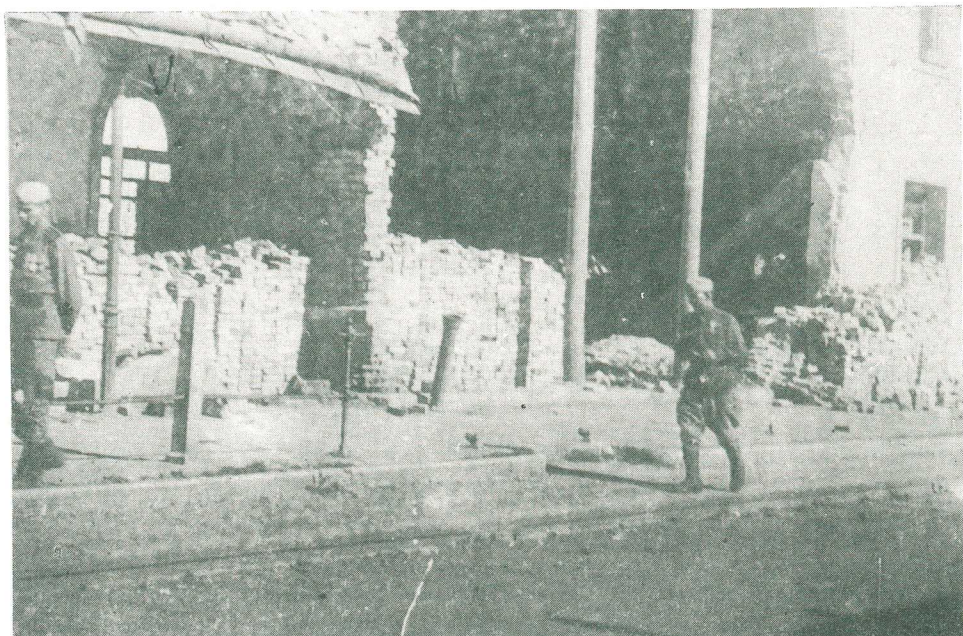
Zničená železničná stanica v Medzilaborciach
