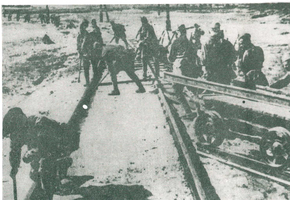
Pomoc sovietskych vojakov pri oprave železničnej trate Humenné — Michalovce
