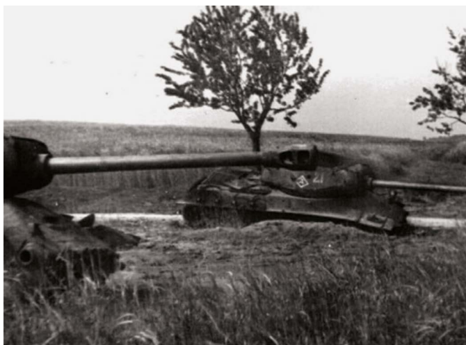
Dva zničené tanky IS-2 u silnice ze Střelice na Troubsko. Na věži tanku s číslem 21 je vidět i rozlišovací znak jednotky. (archiv Milana Coufala)
